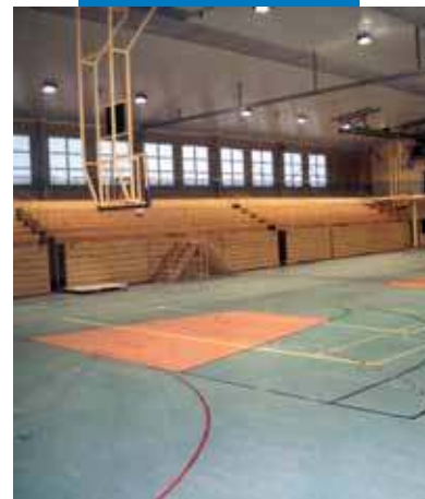
Пример использования Primer G перед укладкой ПВХ и линолеума в спортивном зале - Спортивный зал Гданск Оруна - Польша
