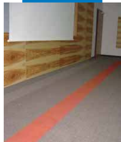
Пример использования Primer G перед нанесением Ultraplan Eco и клея Rollcoll для укладки коврового покрытия в номере отеля - Villa Hotel Castellani - Австрия
